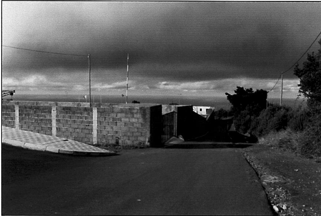
- VIA PERIMETRAL SUR SEMIURBANIZADA. AL FONDO VALLADO DE LA ZONA DE APARCAMIENTO DEL CAMPO MUNICIPAL DE FUTBOL
