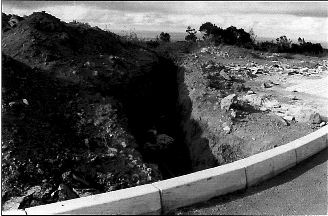
- ZANJA PARA LA CANALIZACION DE CONEXIÓN DE LA RED DE ALCANTARILLADO CON DEPURADORA
